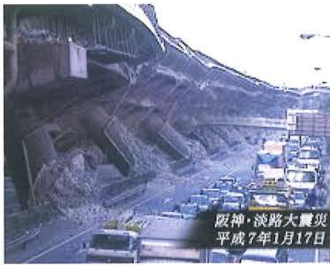
阪神大震災で倒壊した高速道路
